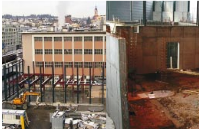
Die Halle für die Erweiterung der Kernmacherei in Emmenbrücke (links) und die Fundamente der zwei neuen Schmelzöfen in Giroud, Frankreich, werden planmässig fertiggestellt.
