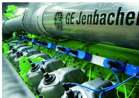
Bild 7: V16 Motor mit Monitoring Ignition Control (Zündspannungsüberwachung).
